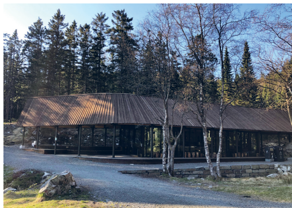
Skomakerstuen sto klar i februar 2020. Skomakerdiket er en fin destinasjon for både voksne og barn, både som mål og stoppested. Foto: Malin V. Jonsson.
