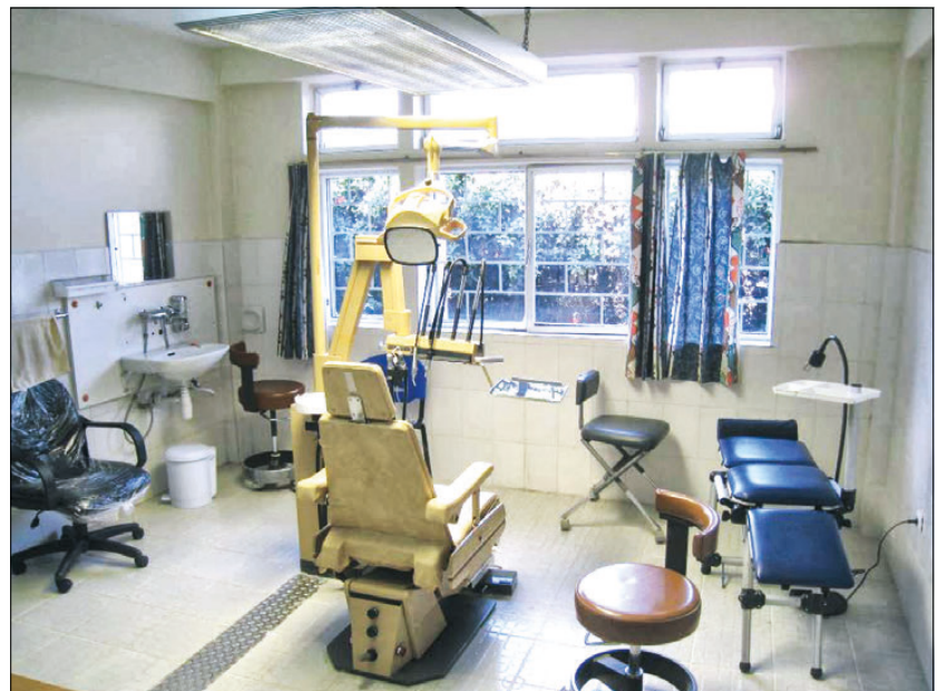
Første etasje ble renoveret til fire fullt utrustede tannlegekontorer, røntgenrom, tannteknikerlab, lesesal og bibliotek.
