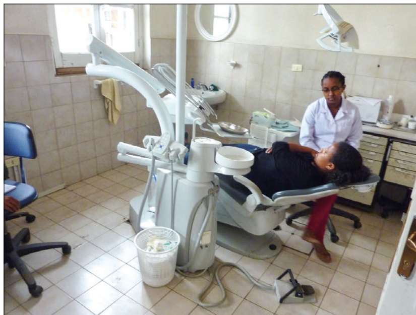
En ny KAVØ-unit (modell 1058) midlertidig installert i DHSTC i juni 2016. Alt annet montert, stuert vekk eller stablet i det store bygget. Strøm, vann tilførsel, trykkluft og vakuumsug ennå ikke tilkople.
