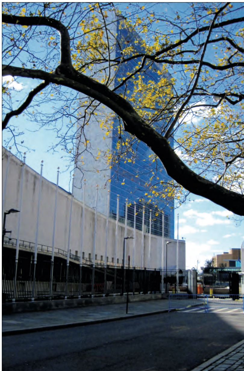
FN bygningen er stengt. Vann i kjelleretasjen.
