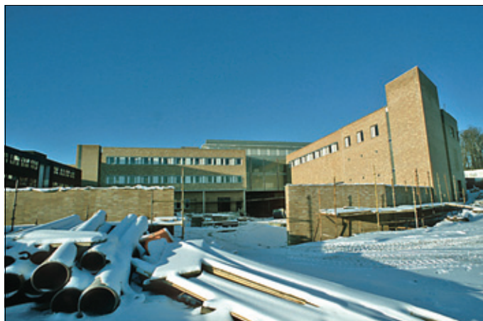
Under oppføringen av Domus Odontologica som huser blant annet Institutt for oral biologi ved det nye Rikshospitalet på Gaustad i Oslo.
