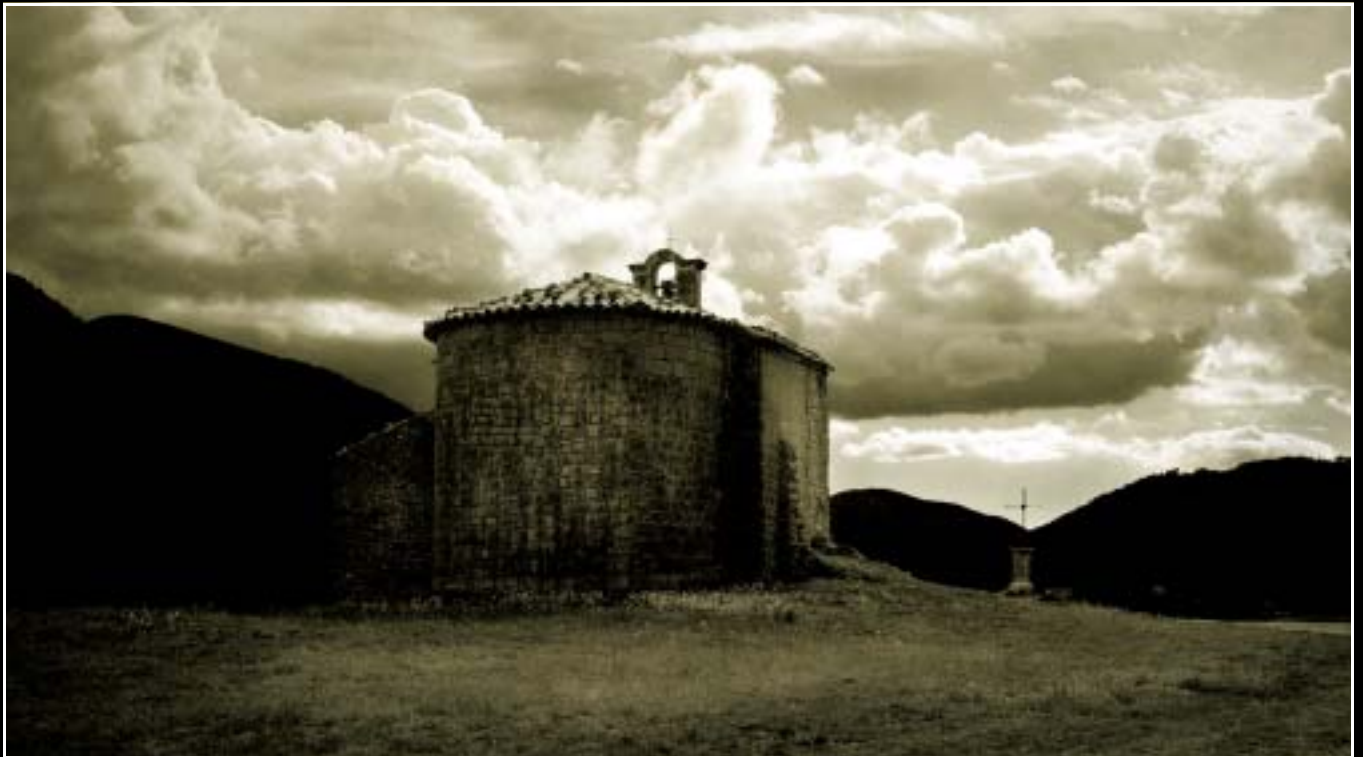
Chapelle Gratemoine. Provence. Foto: tannlege Arne Hvaring.
